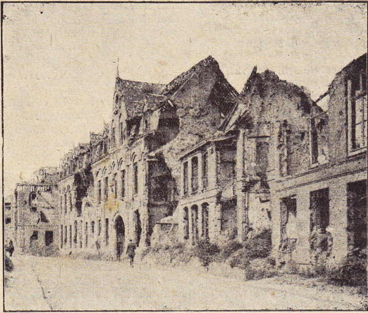
Ieperen. H. Familie kostschool, na de verwoesting.
